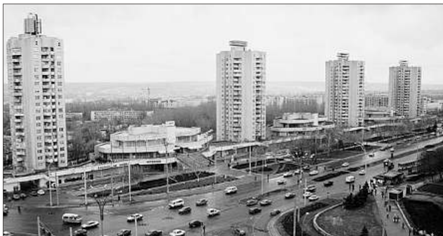
Vedere din Chișinău, Bulevardul Dacia
