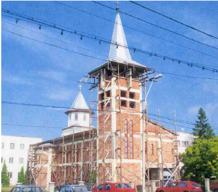
Biserica Armatei, în construcție
