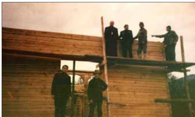
Urmărind lucrările la construcția bisericii (Bârsana, 19 septembrie 1992)
